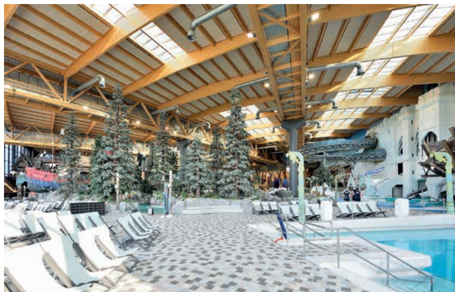
Europa-Park Rust – Montage von: ca. 5.000 qm Holzwole-Akustikdecken, 6.500 qm Aquapanel-Platten Verarbeitung an Torbögen, Metallständerwänden, Vorsatzschalen und Sonder-Wolkendecken.
